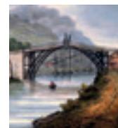
sul fiume Severn – nello Shropshire, in Inghilterra – viene inaugurato l'Iron Bridge. Lungo 30 metri per un peso complessivo di 378 tonnellate, si trattò del primo ponte metallico nella storia delle costruzioni. Venne concepito sia per rendere efficienti i collegamenti stradali (vitali per le nascenti attività industriali) sia per dare una dimostrazione delle potenzialità della produzione siderurgica
